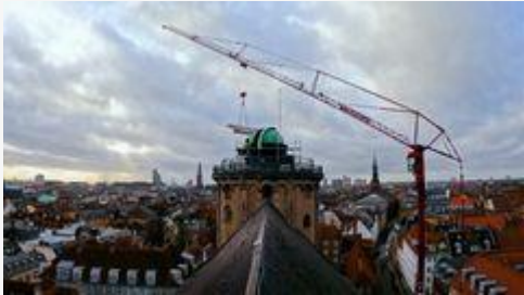
Stilladsdele løftes op med kran
